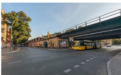
Die Eisenbahnüberführung „Wollankstraße“ aus Blickrichtung Süden (Juli 2023) [Quelle: Martin Kaule]
