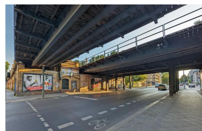
Die beiden Brückenelemente der Eisenbahnüberführung „Wollankstraße“ werden durch einen Neubau ersetzt (Juli 2023) [Quelle: Martin Kaule]
