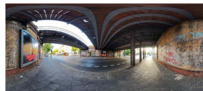
Panoramaaufnahme mit Standpunkt unterhalb der Eisenbahnüberführung „Wollankstraße“ (Juli 2023) [Quelle: Martin Kaule]
