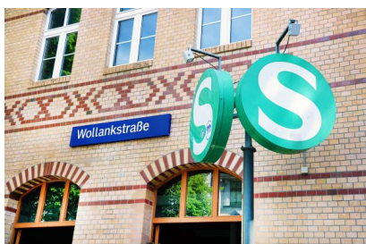
Das Empfangsgebäude des S-Bahnhofs Wollankstraße an der Nordbahnstraße (Mai 2023) [Quelle: DB Netz AG]
